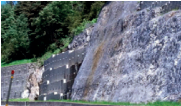
Murs de formigó a la carretera d'Ordino al Serrat. Foto: XLM
