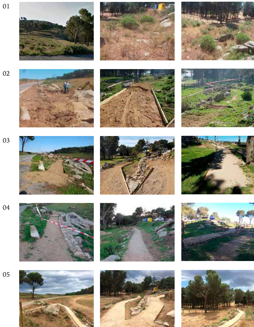
Fig. 8. Camí adaptat. 01. Estat inicial: paisatge existent abans de les actuacions 02. Fase 1: lleuger moviment de terres per marcar el camí i col·locació de límits perimetral de fusta. 03. Fase 2: col·locació d'una capa de grava a sobre del terreny existent. 04. Fase 3: construcció i consolidació de murs de pedra seca. 05. Fase 4: col·locació de paviment de fang i calç (2017). Amanda Soler i Vela; Xavier Laporta Benito.
