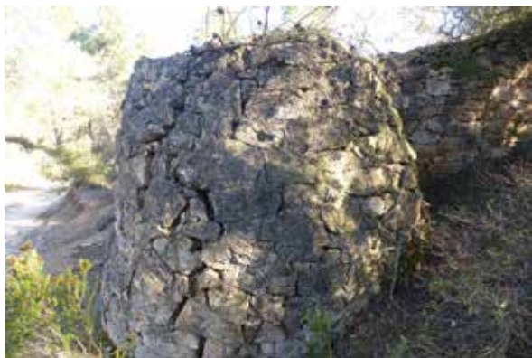
Fig. 5. La Cisterna de la Ginera del Xifrenet. Imatge lateral amb escletxes (2015). Font: Ramon Maria Arbós.
