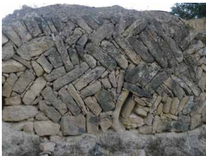
Imatge 9. Tècnica de col·locació inclinada, 2018. Font: F. Xavier Solé.
