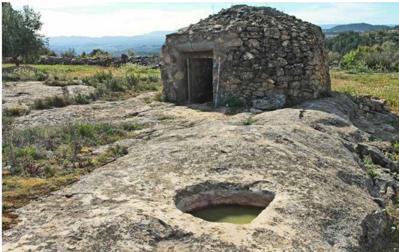
Fig. 9. Aljub excavat a la roca que recull l'aigua de pluja per escorrentia. Al costat, una cadolla. 2006. Font: Josep Preixens. Arxiu propi.
