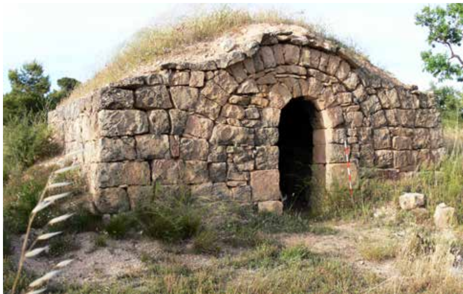
Fig. 4. Cabana coberta amb volta de canó. 2010. Font: Mateu Esquerda. Arxiu propi.
