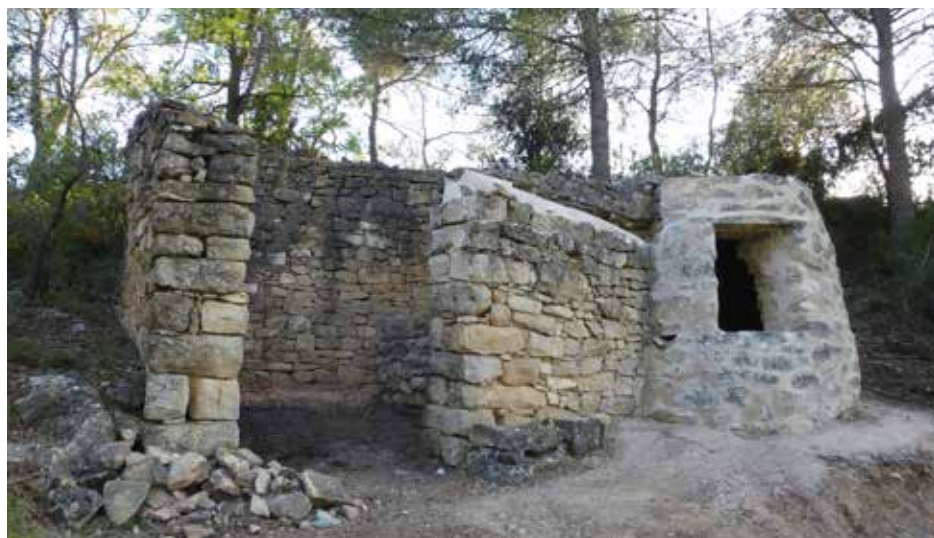
Fig. 6. La Cisterna de la Ginera del Xifrenet un cop consolidada (2015). Font: Ramon Maria Arbós.
