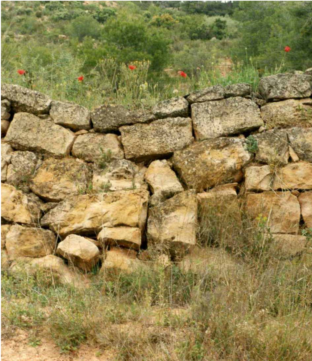
..... Imatge 4. Enderroc per l'acció de l'aigua, 2018 Font: F. Xavier Solé
