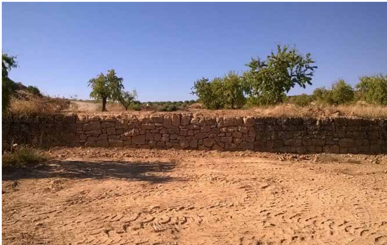
..... Fig. 10. Marge reconstruït en el tram afectat pel pas de la xarxa de reg. Terme municipal d'Alfés. Font: ASG, 2018.
