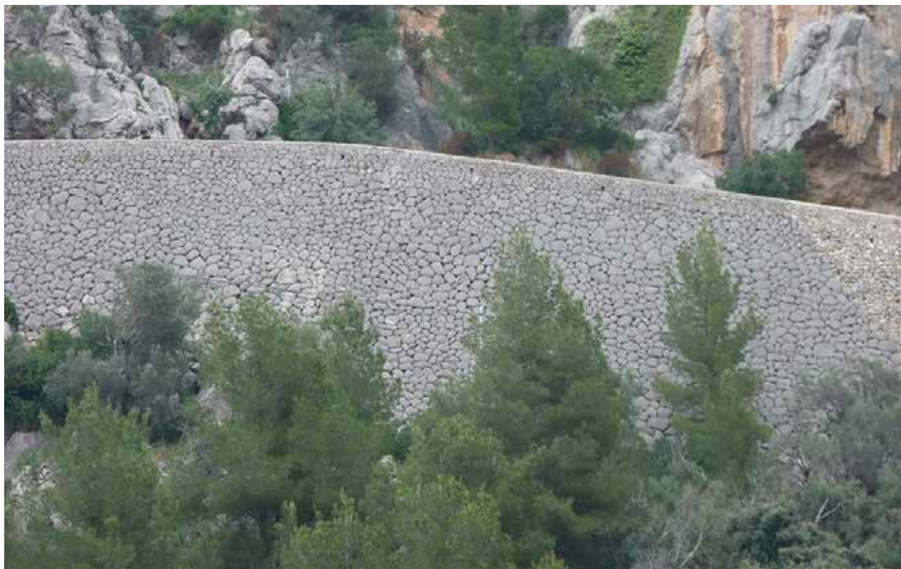
Foto 3. Mur de sustentació de carretera de fins a 13 m d'altura. Font: Unitat de Pedra en Sec. Departament de Medi Ambient.
