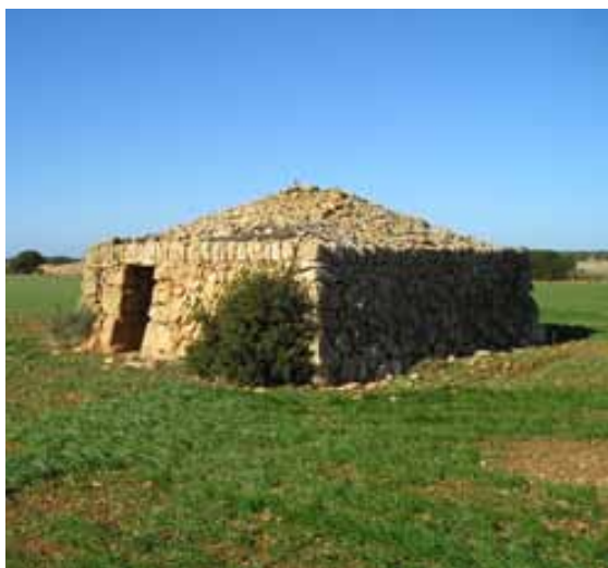
Figura 11. Barraca de curucull a ses Rotes Noves de Torràltx (Àguila d'en Quart).
