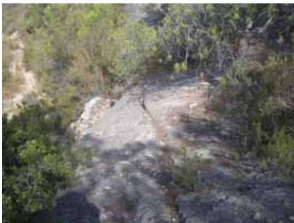
Figura 8. Regatera o canal per facilitar l'entrada de l'aigua a l'anjub. Anjub de la Pererola de Ca la Pastora.
