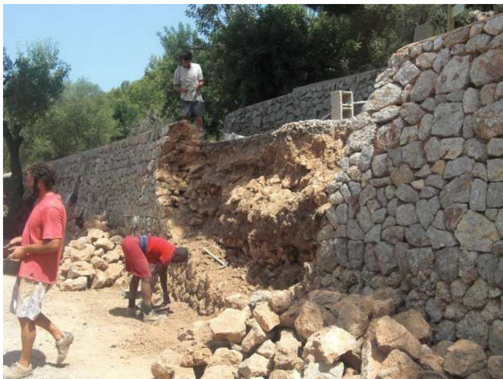
Figura 1. Imatge de les feines de recuperació de marges a la finca pública de Planícia.
