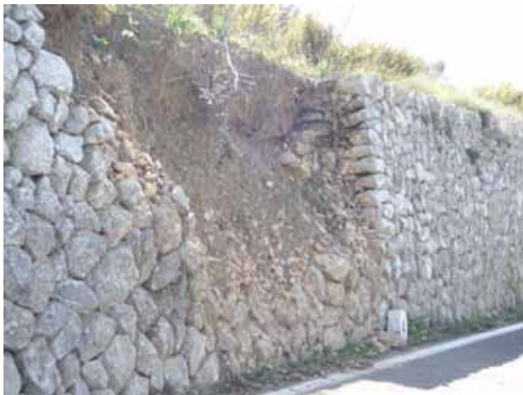
Figura 10. Aquest esbaldrec de Randa ens mostra com la base no participa de la resistència a l'empenta del terreny.
