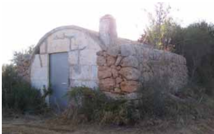
Figura 20. Barraca d'establidor a Bennoc (pol. 44 - parc. 208).
