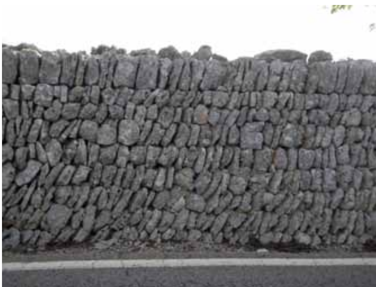
Figura 5. A la carretera de Felanitx a Porreres trobem aquesta paret clàssica: petits blocs col·locats en filades lleugerament inclinades, i una pàtina grisa salpebrada de líquens.
