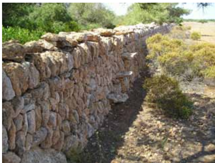
Figura 2. Paret seca amb un botador a na Gropa (es Carbonells).
