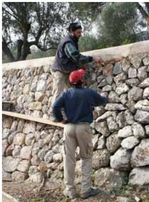
Figura 8. Rehabilitació d'una paret del jardí.
