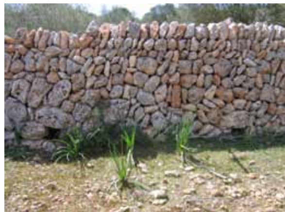
Figura 4. Paret seca amb dues clavegueres d'aigua (es Camp Gran – cas Frares).
