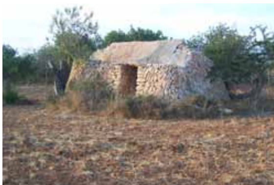
Figura 18. Barraca d'establidor a Bennoc (pol. 44 - parc. 235)
