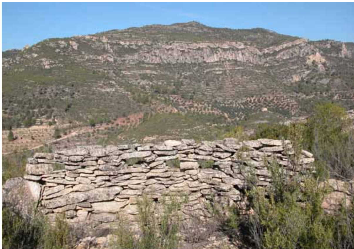
Figura 9. Antics parapets de defensa construïts amb pedra en sec, als Montalts.
