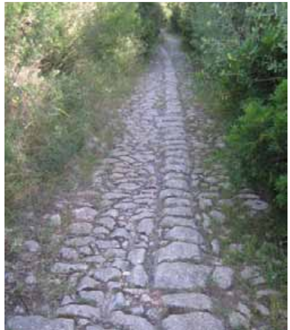
Figura 8. Camí empedrat amb lloses posades de pla. Es pot apreciar una espina central o faixa longitudinal formada per lloses més grans probablement col·locades de cantell. També es poden apreciar unes faixes transversals a distàncies regulars.
