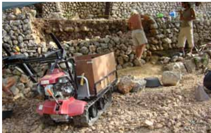
Figura 5. L'eruga, una mena de carretó autopropulsat que pot transportar fins a 300 kg de pedres és l'única eina propulsada per combustibles fòssils que es pot usar al barranc i no arriba a tots els llocs.
