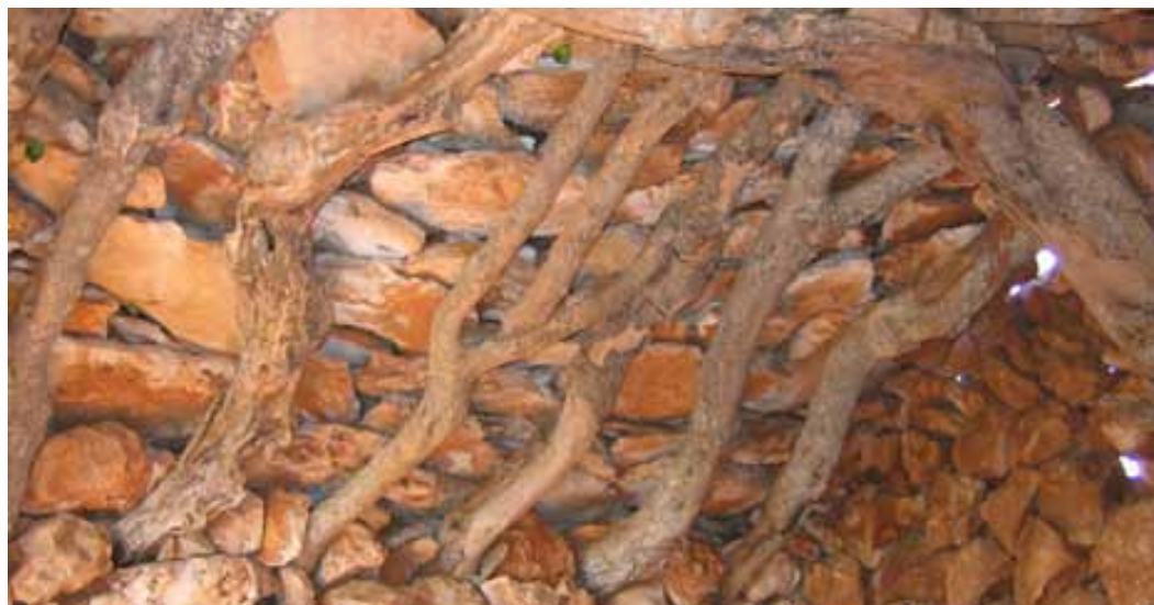
Figura 7. Coberta d'una barraca a na Pau (Àguila d'en Quart).
