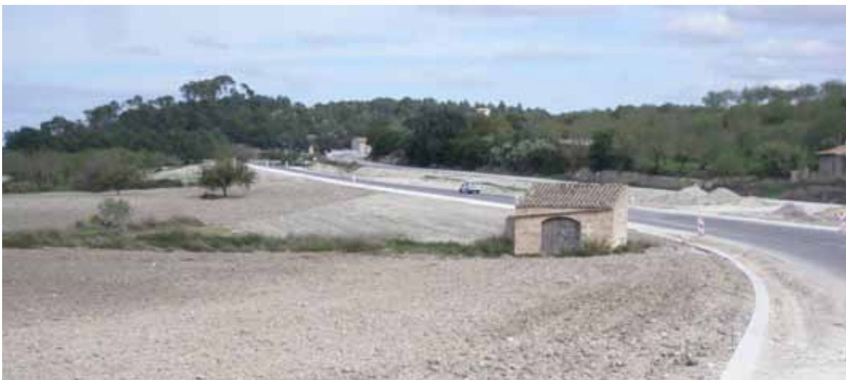
Figura 6. A la carretera de Montuïri a Sant Joan s'han anivellat els camps amb la plataforma de la carretera, eliminant-ne els desnivells i reduint així el perill de les sortides de via.
