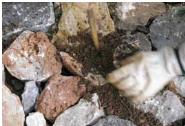
Figura 4. El garrot s'utilitza per compactar la terra.
