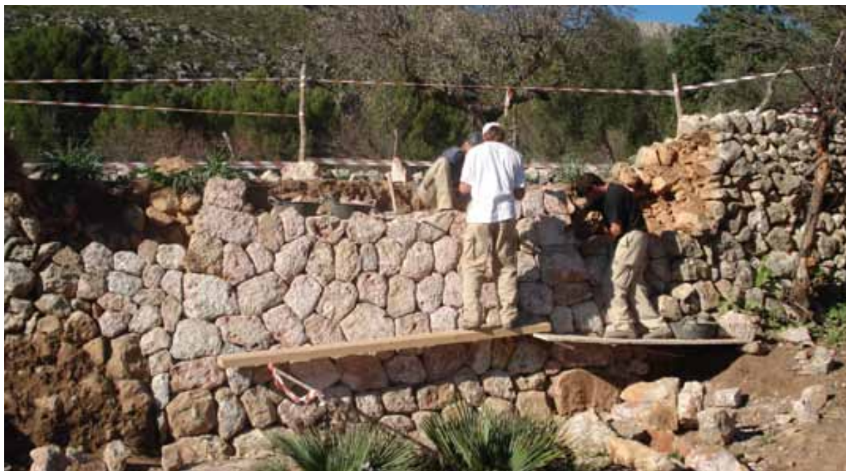
Foto 9. Rehabilitació d'un marge
