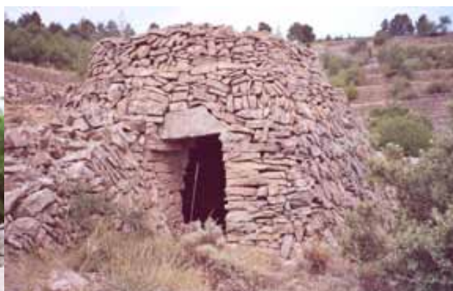
Figura 18. Caseta amb coberta vegetal.
