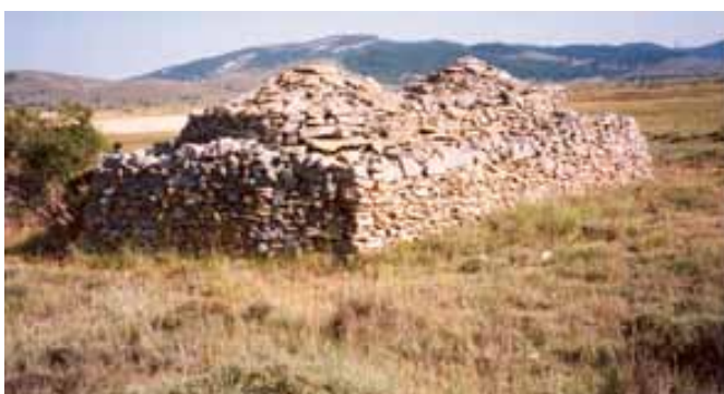
Figura 12. Caseta de doble recinte.
