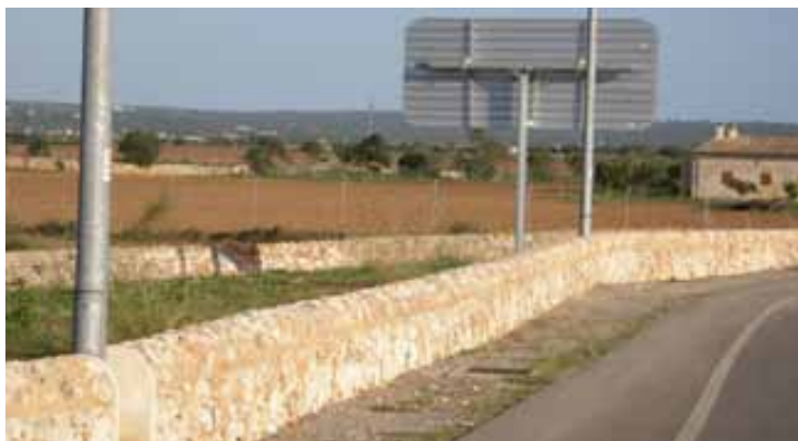
Figura 7. En aquesta rotonda entre Campos i sa Ràpita s'ha emprat la paret de tancament com a contenidor dels elements perillosos per als vehicles.
