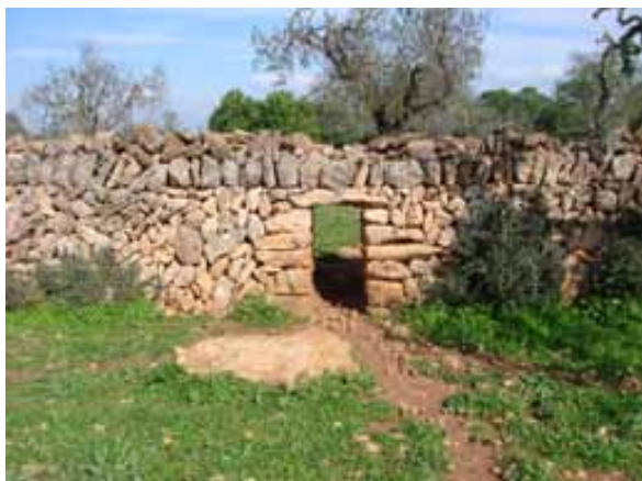
Figura 3. Paret seca amb una claveguera de bestiar (s'Hortal Nou – es Carbonells).
