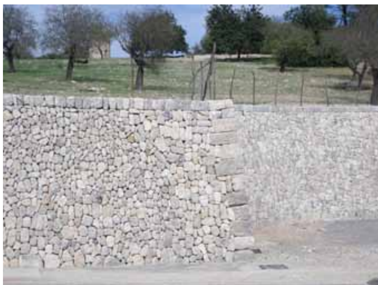
Figura 11. Aquest mur de cinc metres d'alçada a la carretera de Montuiri a Sant Joan està fet de formigó en massa, recupera les pedres de l'antic marge i la seva trama característica, i evita que es vegin els drenatges.
