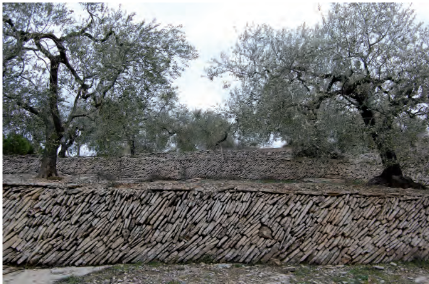
Paret seca en un olivar de Torre de Fontaubella al Priorat (A. Sabaté)
