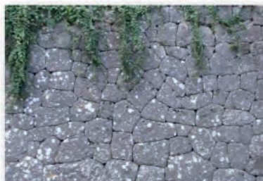
Paret pedra encaixada (sense falques)
