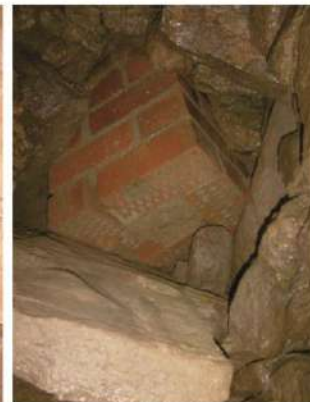
7. ENFONSAMENT PROVOCAT PER INTERFERÈNCIA DE CONSTRUCCIÓ CONTEMPORÀNIA
