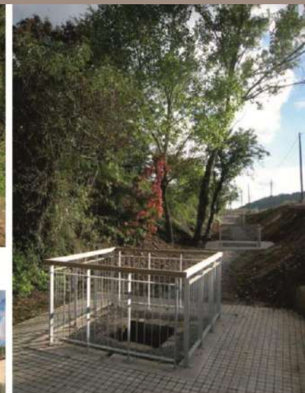
4. POUS DE VENTILACIÓ 1 A 3
