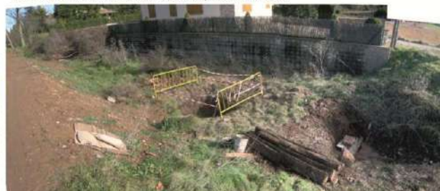
5. POU DE VENTILACIÓ PARCIALMENT SOTERRAT, DES DE L'EXTERIOR
