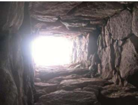
15. POU DE VENTILACIÓ 3
