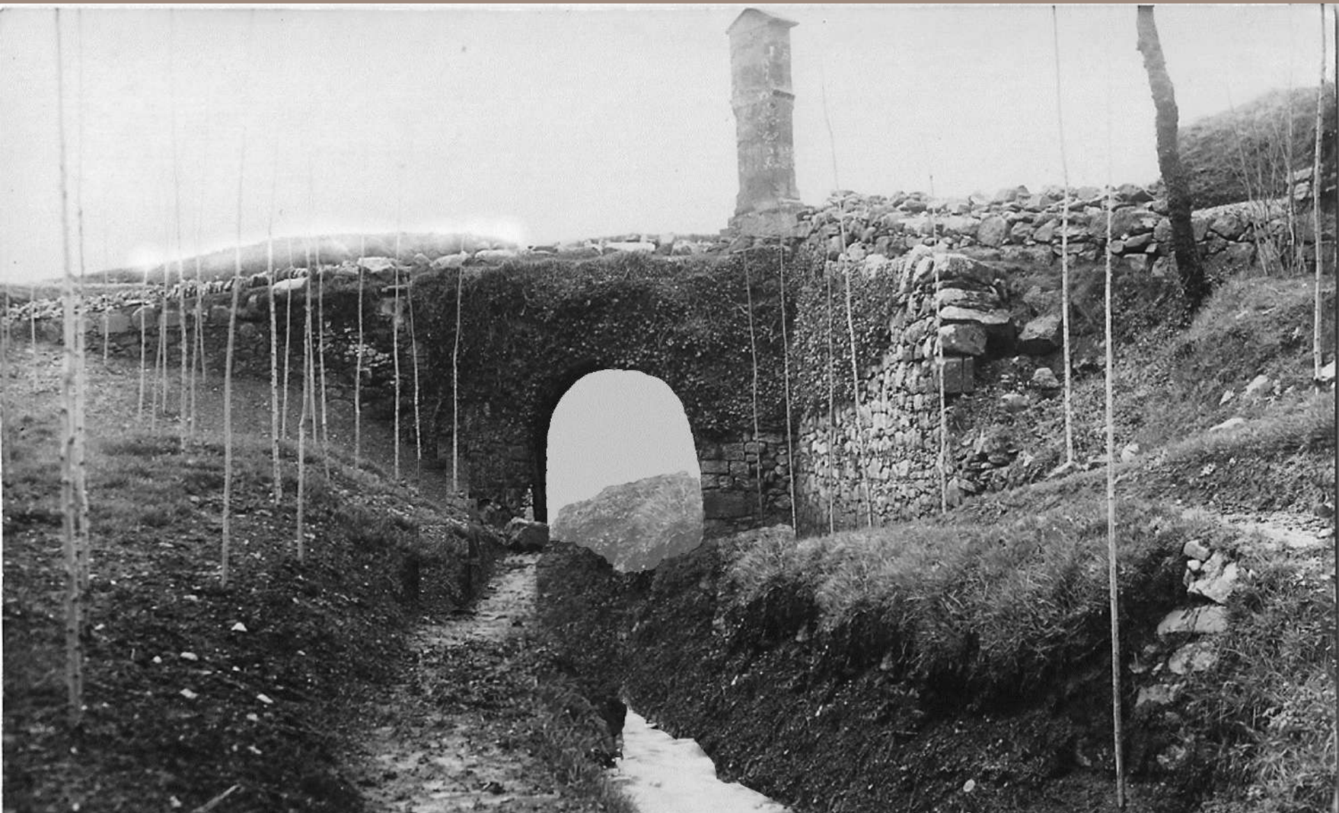
Restauració de la galeria de pedra seca de la Mina del Monestir de l'Estany
