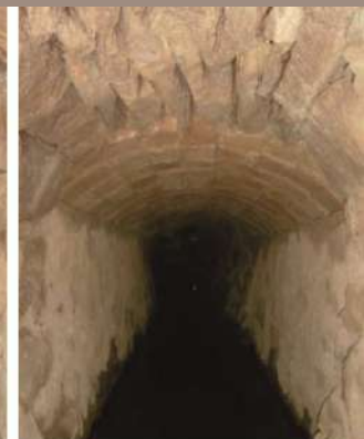
5. TRAM REPARAT AMB VOLTA DE MÀO DE PLA
