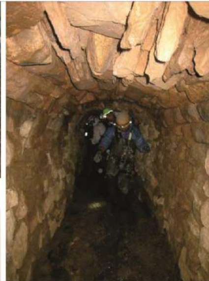
22. INTERIOR DE LA GALERIA – TRAM REC A BOCA NORD
