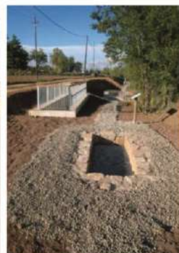
7. POU DE VENTILACIÓ 5
