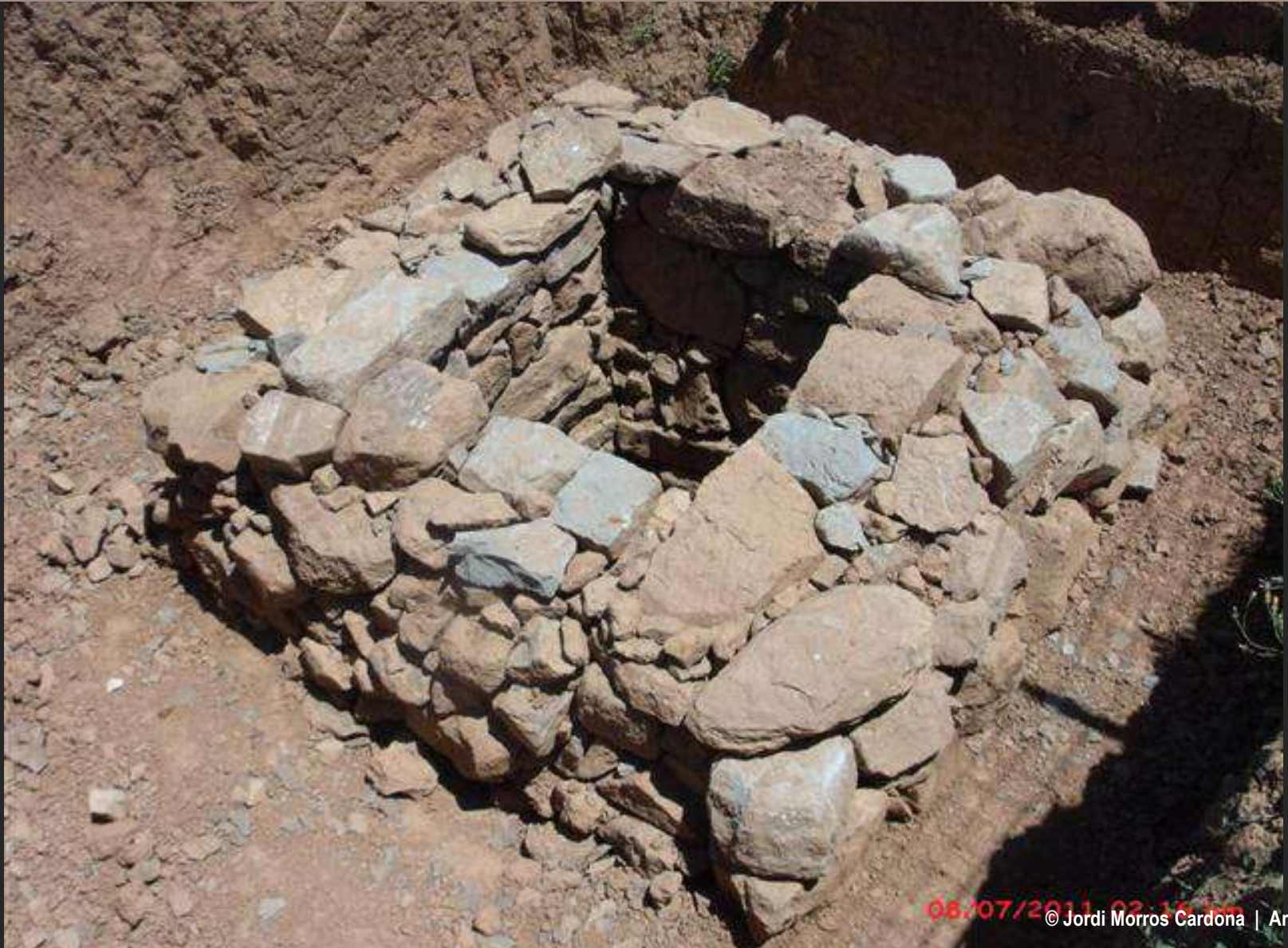
Restauració de la galeria de pedra seca de la Mina del Monestir de l'Estany
