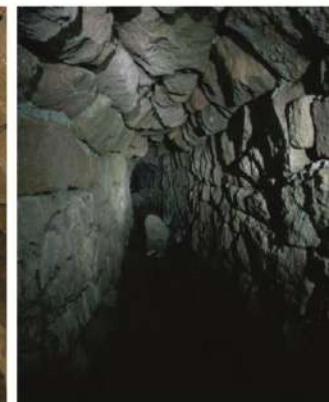
9. DESPRENIMENT LOCAL DE LA VOLTA
