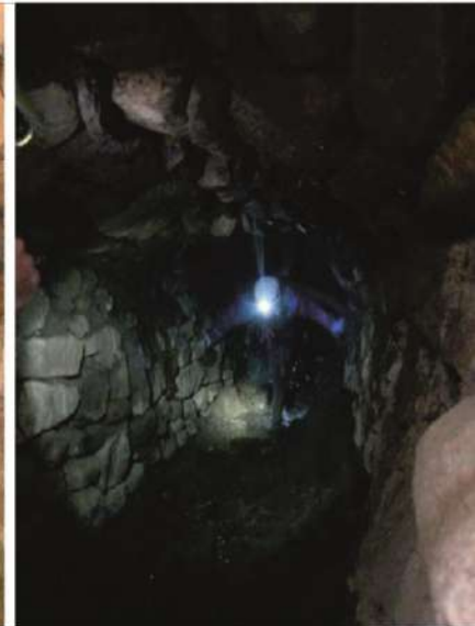
24. INTERIOR DE LA GALERIA – TRAM REC A BOCA SUD
