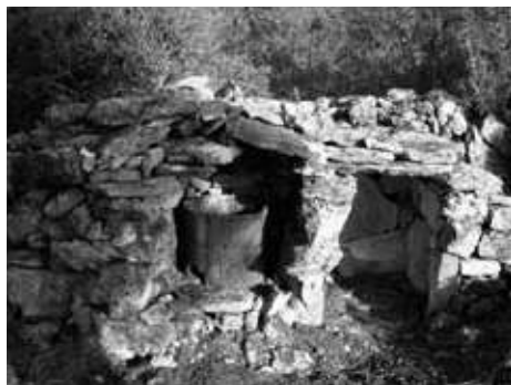
Ameres estat inicial i després de les obres de restauració
