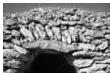
Fig. 1: Llanda suficient amb arc de descàrrega
