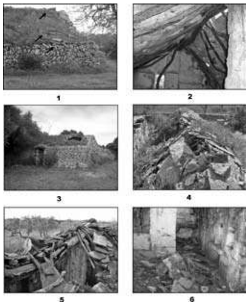
Figura 1: 1.- Estadi 2: Barraca d'es Tancat Prim. 2.- Estadi 3: Barraca de Can Puig. 3.- Estadi 4: Barraca d'es Ferreret. 4, 5 i 6.- Estadi 5: Barraca de Can Puig.
