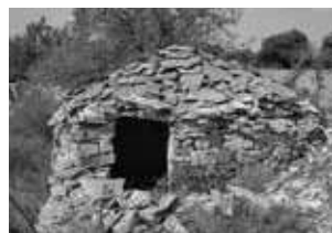
Barraca de vinya localitzada en l'estudi d'impacte sobre el patrimoni del Parc Eòlic Pujalt.
