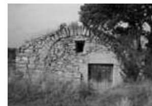
Cabana de volta localitzada en l'estudi d'impacte sobre el patrimoni de la línia elèctrica de la Granadella.
