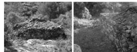
Detall de l'obra de restauració, esquerra estat inicial i dreta final
