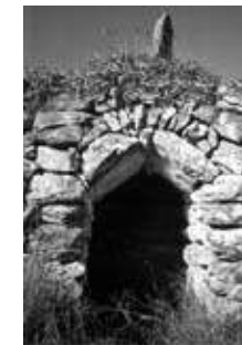
Fig. 4: Portal d'angle amb arc de descàrrega
