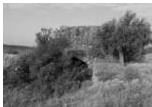
Forn d'obra localitzat en l'estudi d'impacte sobre el patrimoni del Parc Eòlic de Montclues.
