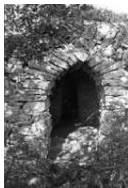
Fig.12: Arc amb la clau desplaçada
