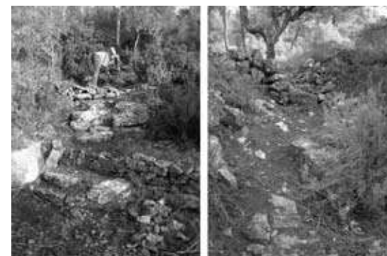
Obres de millora del recorregut, emprant les tècniques tradicionals
