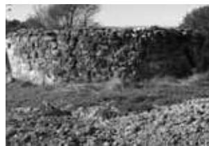
Cisterna construïda localitzada en l'estudi d'impacte sobre el patrimoni del Parc Eòlic de Mudèfer, vista de l'exterior.
