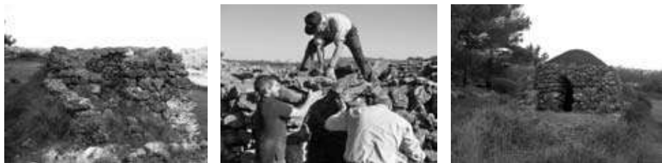
Abans, durant i després de la restauració d'una barraca de mas Roig a Begues (octubre 2007)
