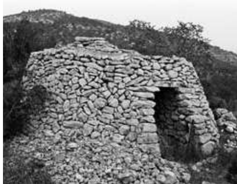
Figura 2: Barraca actualment enrunada, tal i com estava en 1977 (nº 41). En aquells moments una simple acció de manteniment —la col·locació de terra a la part superior— n'hagués permès la conservació (foto: E. Riu-Barrera).
