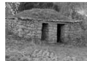
Barraca de vinya doble localitzada en l'estudi d'impacte sobre el patrimoni de la carretera C-37.
