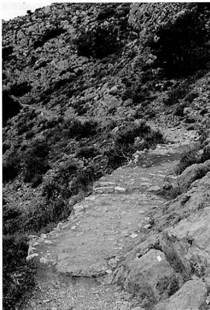
Rehabilitació del camí empedrat de Santa Caterina
