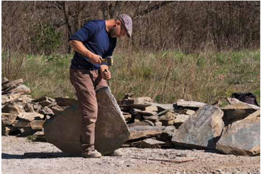
Figura 53 | Marger tallant una llosa de pissarra. | © Noël Hautemanière.
