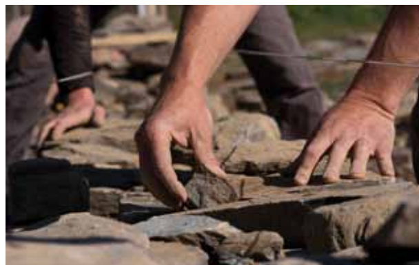
Figura 52 | L'encaix de pedres, un gest essencial en la construcció en pedra seca. | © Noël Hautemanière.
