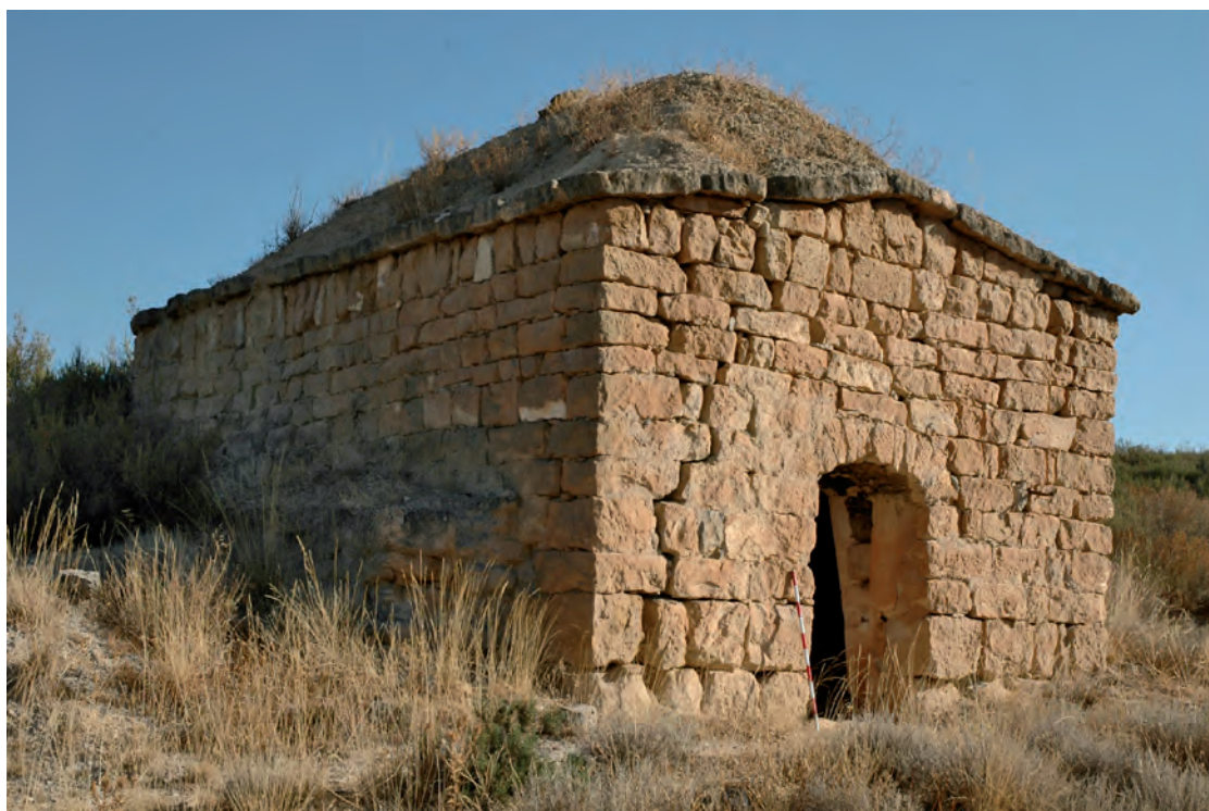
■ Cabana del Sisquet. Cabana de pedra seca amb coberta de falsa cúpula. En un principi —com les de volta de canó— estarien destinades a resguardar l'animal (mula o ruc) dels freds de l'hivern i a la curta o a la llarga foren aprofitades igualment pels pagesos, que en casos determinats fins i tot hi pernoctaven.
