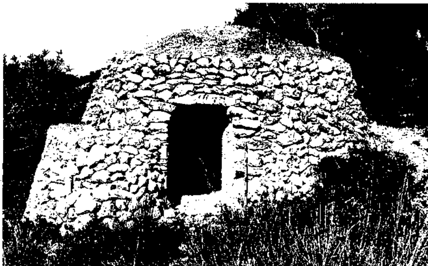
Fotografia 1. Barraqueta amb un reforçament en dels costats i amb un llindar i un arrebossat de ciment al corredor, per acollir una porta actualment desapareguda (construcció núm. 31).
