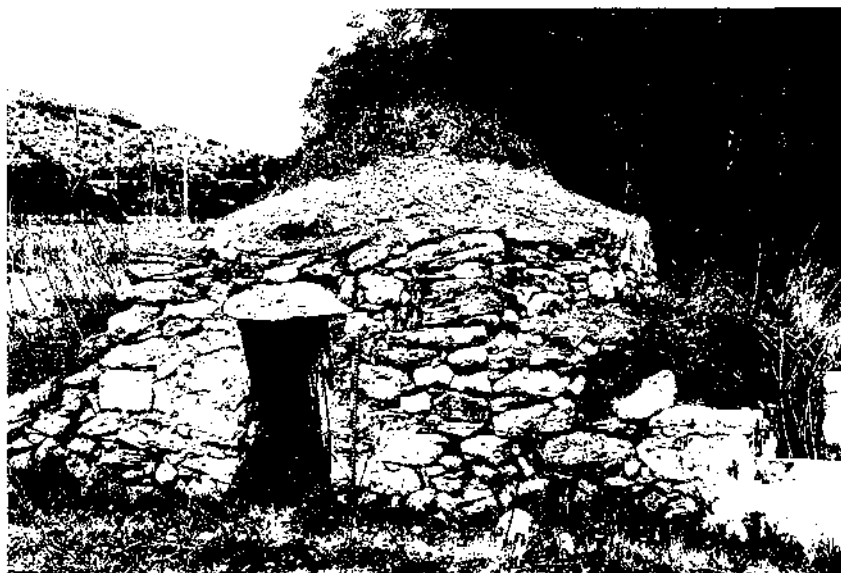
Fotografia 3. Barraca amb reforç exterior perimetral, un safareig i marges adossats a ambdós costats, arrebossat de ciment a la façana (amb la data 1908) i als muntants i lliris a la coberta (construcció núm. 44).
