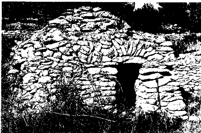
Fotografia 2. Barraqueta adossada a un marge, amb llinda mixta i coberta molt erosionada (construcció núm. 9).
