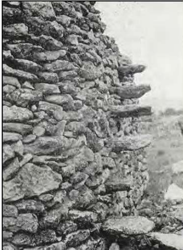
Escaleta adossada al mur exterior, per tal d'accedir a la coberta, situada a Santes Creus.
