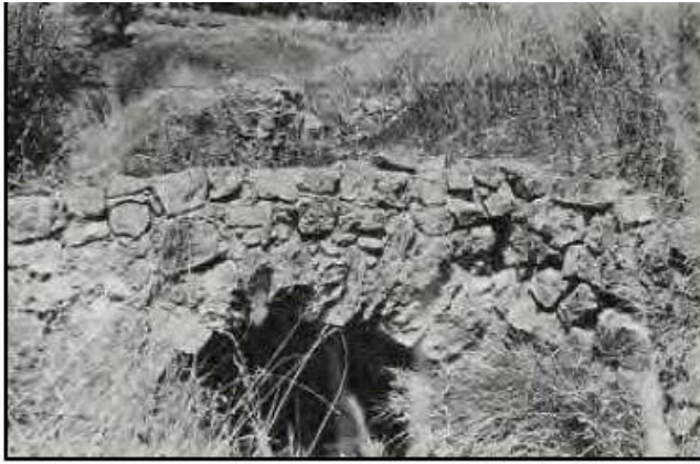
Pont de pedra, a prop d'Espoia, de construcció recent, de directriu semicircular formant una volta de canó seguida
